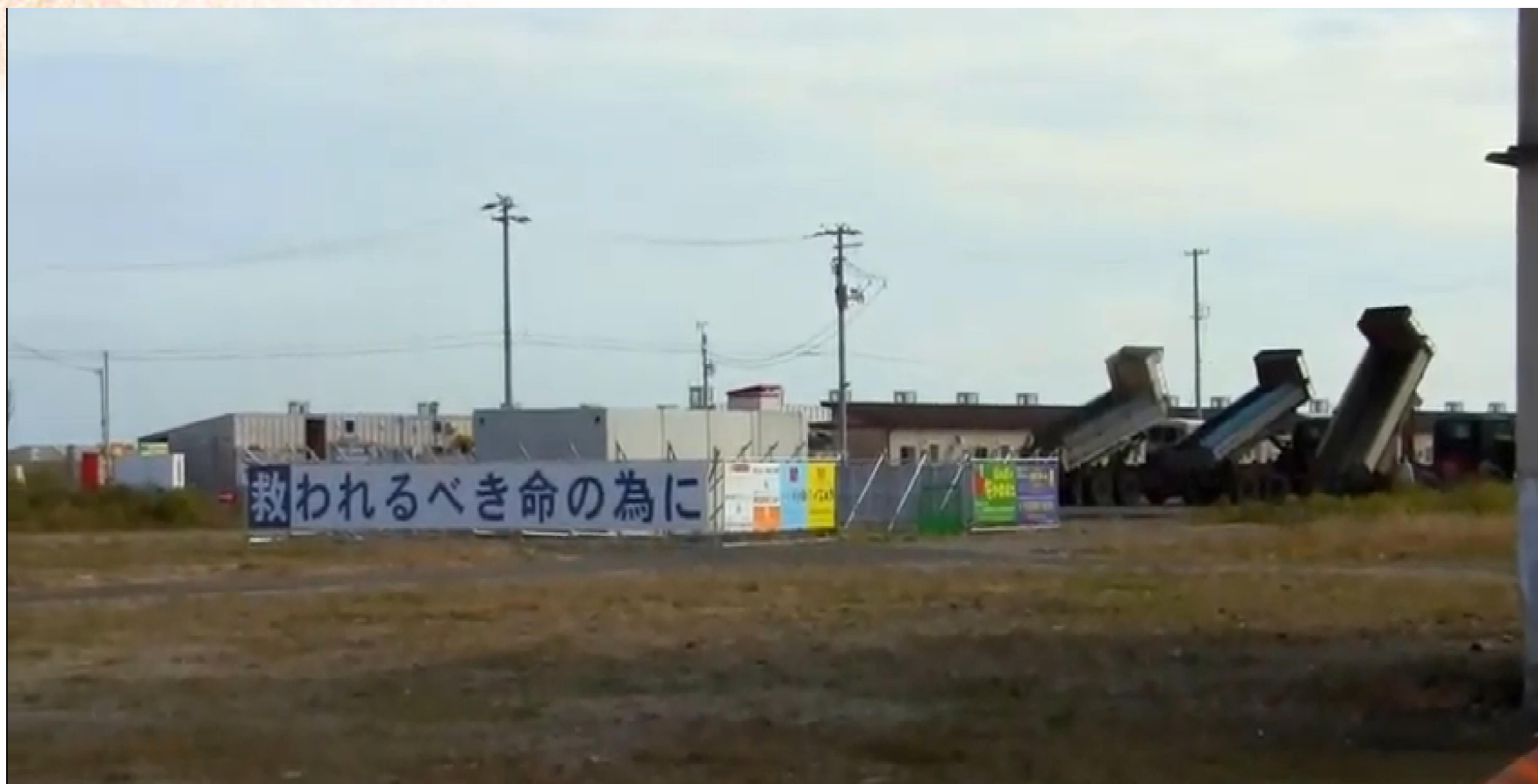
2014年10月 名取市 関上地区 東日本大震災復旧工事現場
