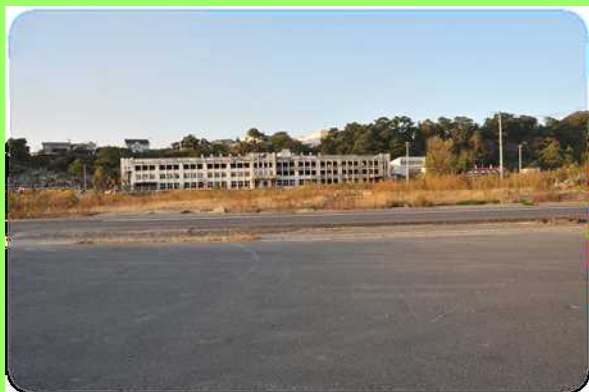
2012年12月 神奈川シニア連合 3.11復興支援被災地研修旅行 石巻市門脇小学校（津波によるガスボンベ等が破裂による被災）
